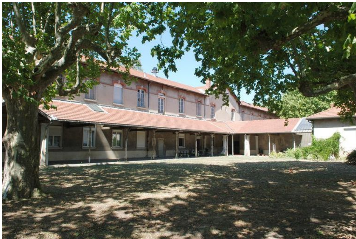
Bâtiment 456-457, façade postérieure (est), partie sud
