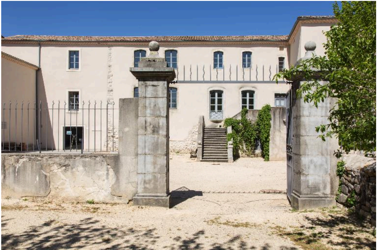
Bastide : entrée sur cour intérieure côté sud
