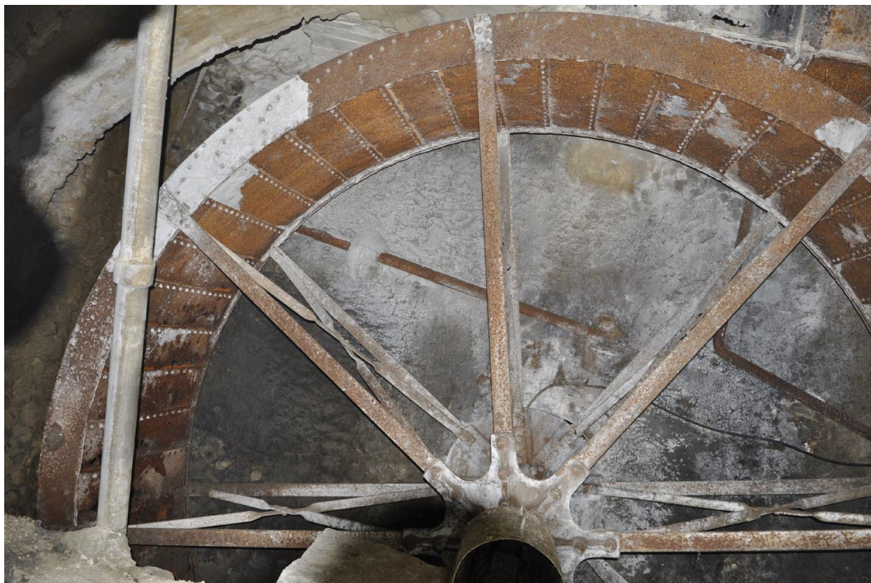
Roue de l'ancien système hydraulique (vue d'intérieur)
