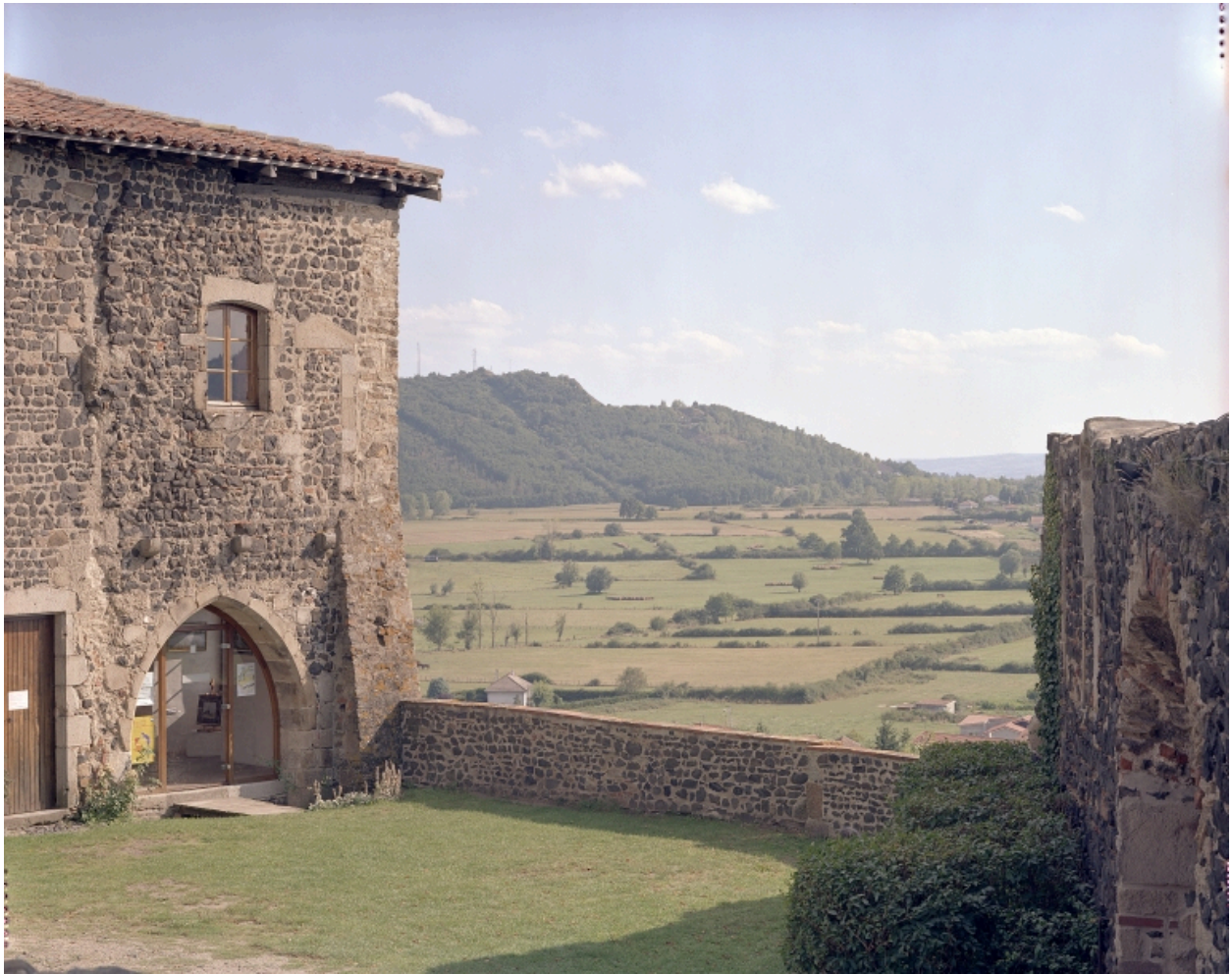
Vue depuis la courtine sud du prieuré, vers l'est
