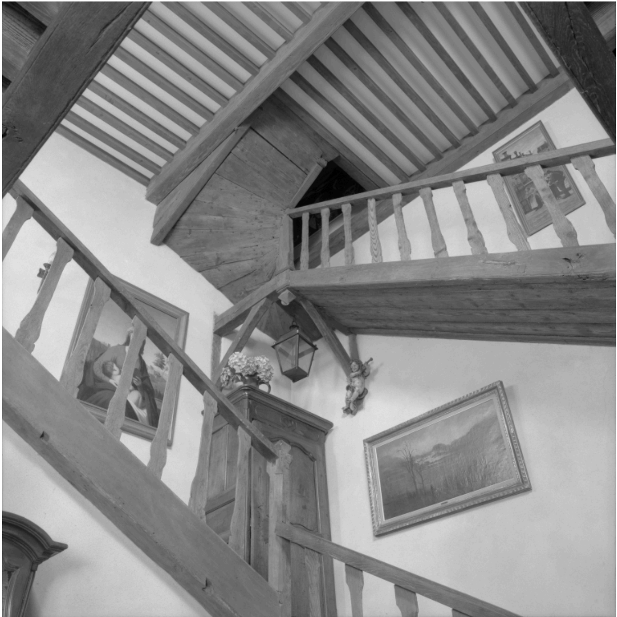
Vue d'ensemble de l'escalier.
