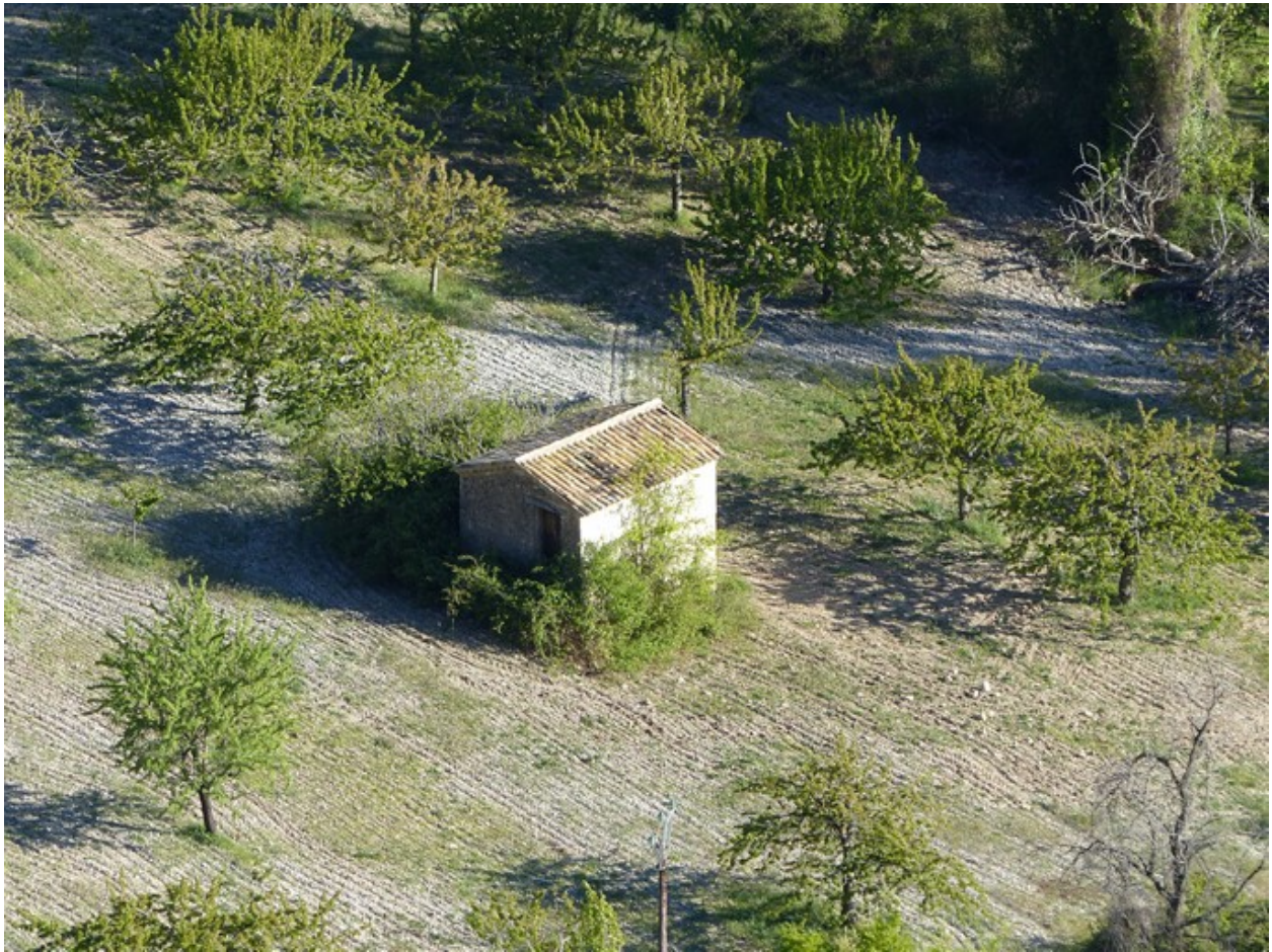
Vue d'ensemble prise du nord-ouest.
