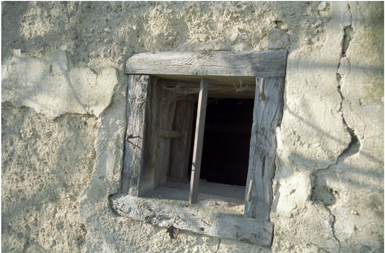
Baie au rez-de-chaussée de la façade antérieure.
