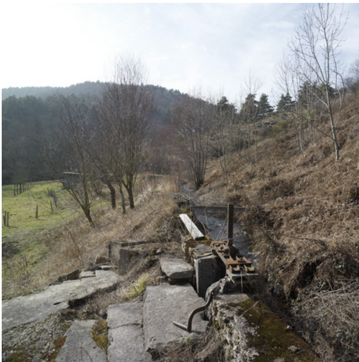
Vue du bief et de la vanne en amont de la chute.
