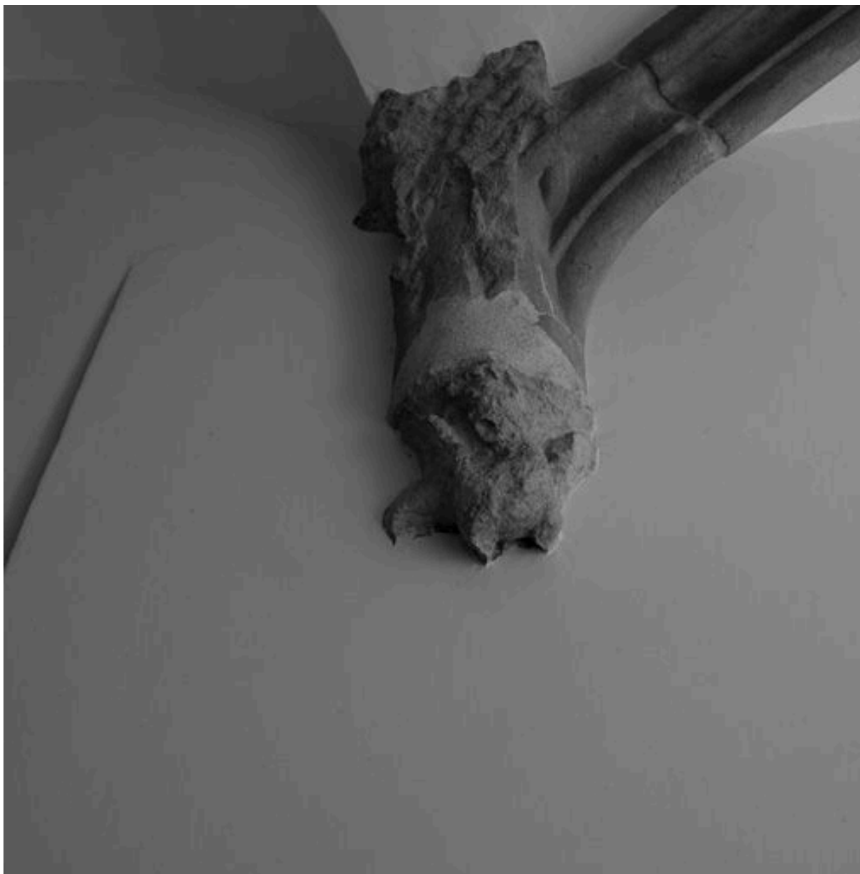
Voûte de l'allée, détail du culot 1
