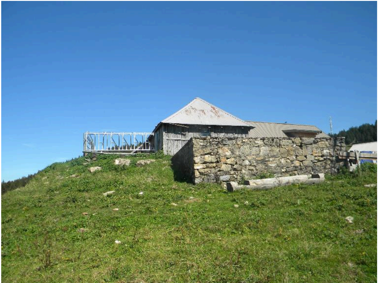
Vue du pignon sud du bâtiment ancien avec fosse à fumier au premier plan.
