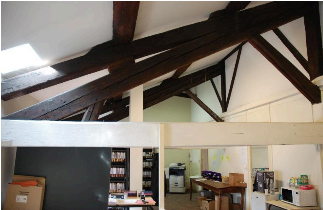
Cour d'honneur, corps de bâtiment est : comble, partie aménagée, détail de la charpente
