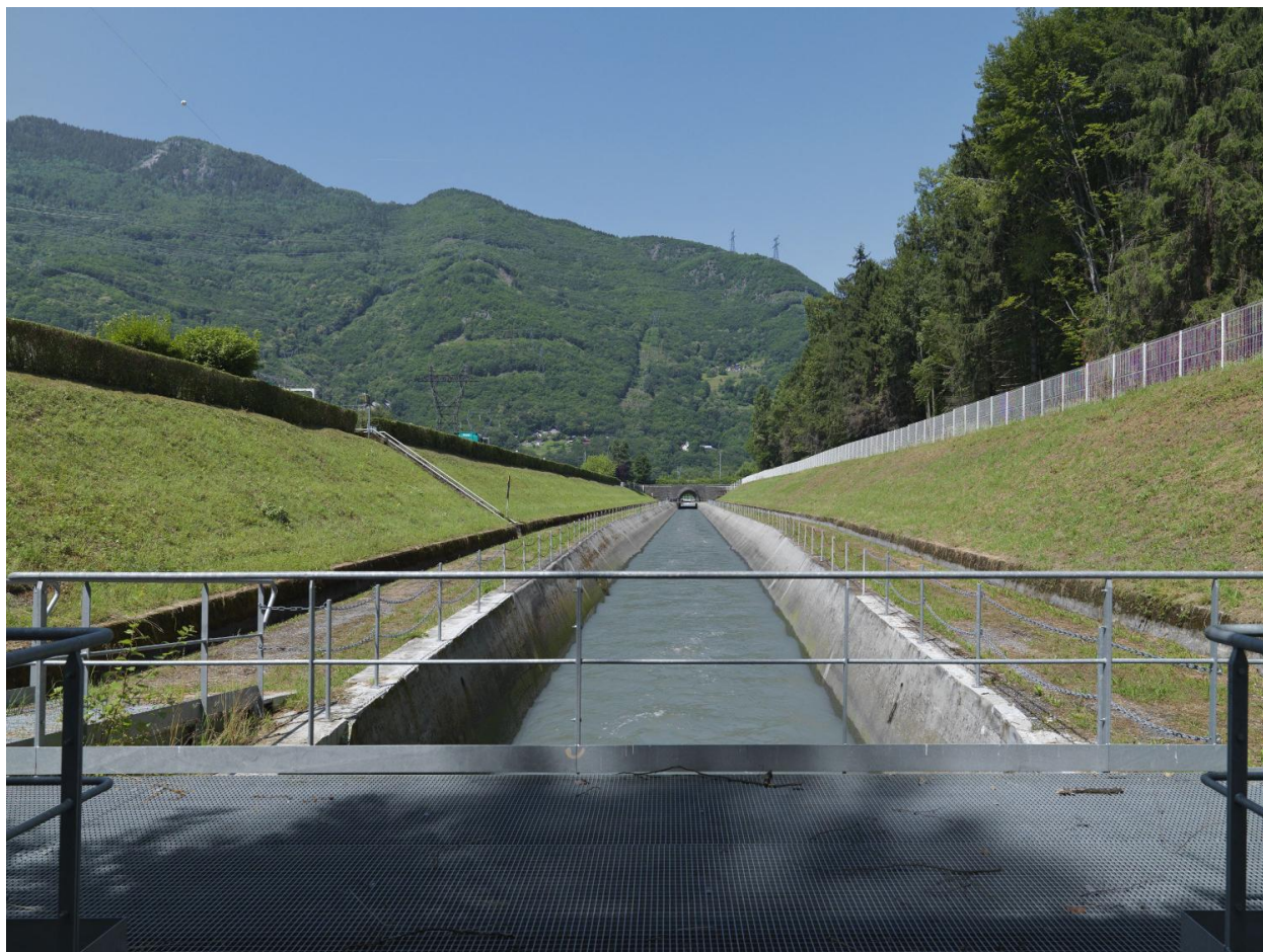
Vue du canal de fuite vers l'aval depuis la sortie du tunnel souterrain
