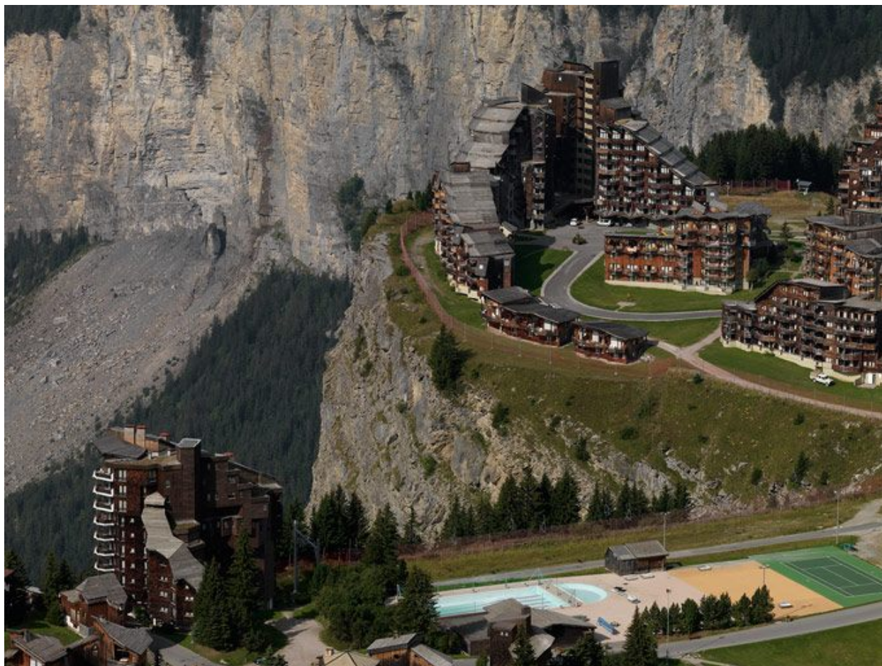
Vue depuis le sud-est
