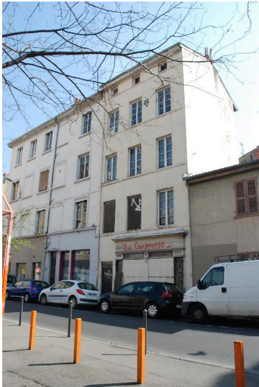
Immeuble démoli, au 39 rue Sébastien-Gryphe (vue prise en 2012)
