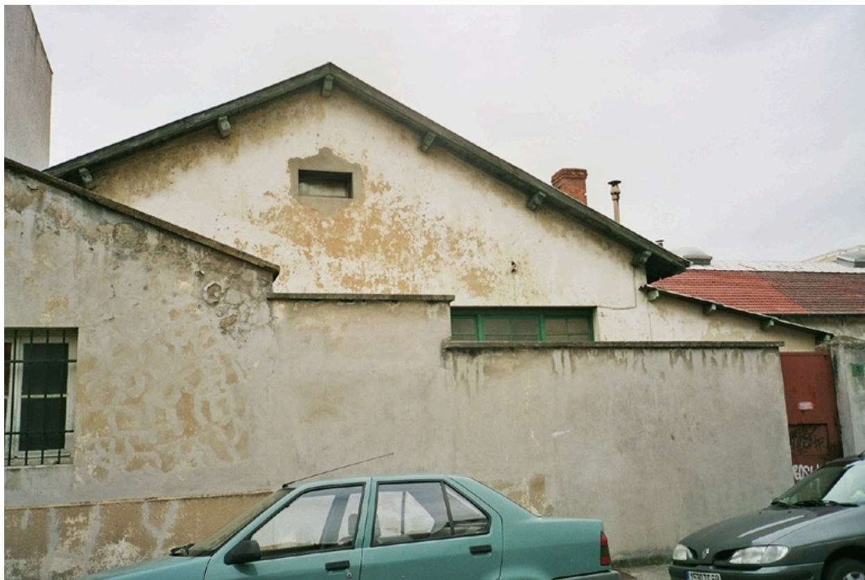
Détail façade est
