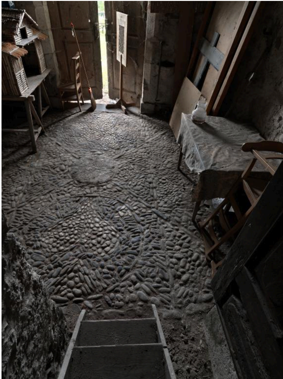
Vue intérieure du clocher : porte vers l'extérieur.
