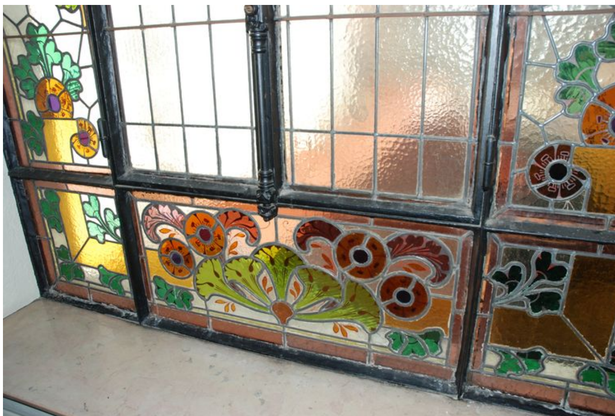
Détail d'une des verrières de la cage d'escalier.
