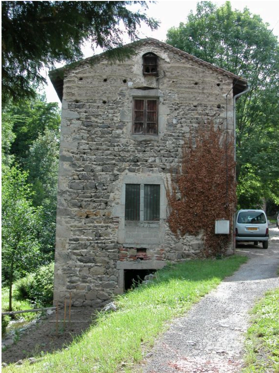
Vue d'ensemble d'un bâtiment agricole attaché au moulin (grange ou garage, fenil)
