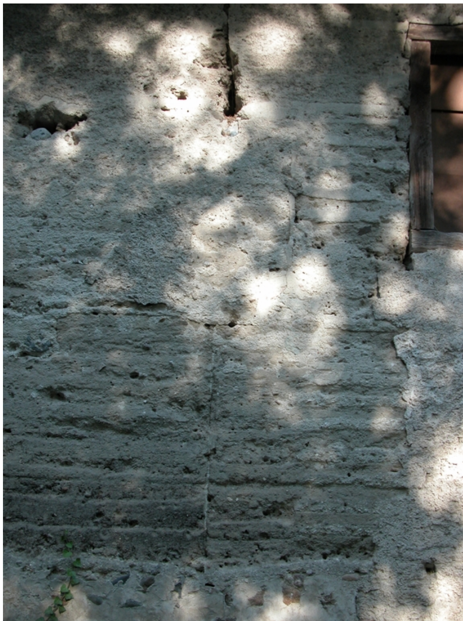
Détail de pisé (mur extérieur ouest).
