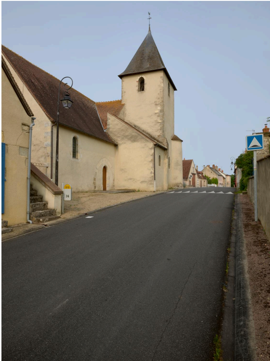
Vue de la façade septentrionale de l'église.
