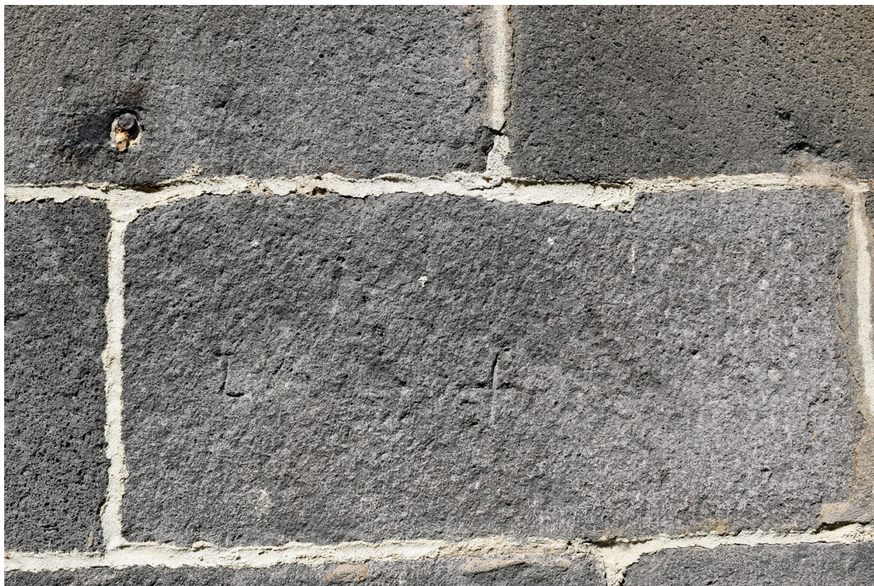
Bâtiment B, élévation sur cour : marque de tâcheron en forme de croix
