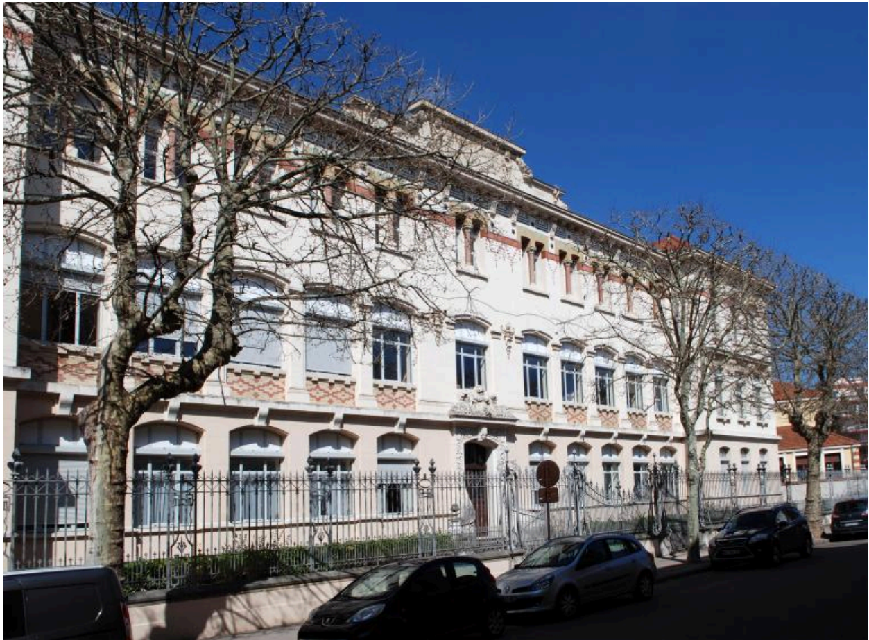
Elévation principale, depuis le sud-ouest
