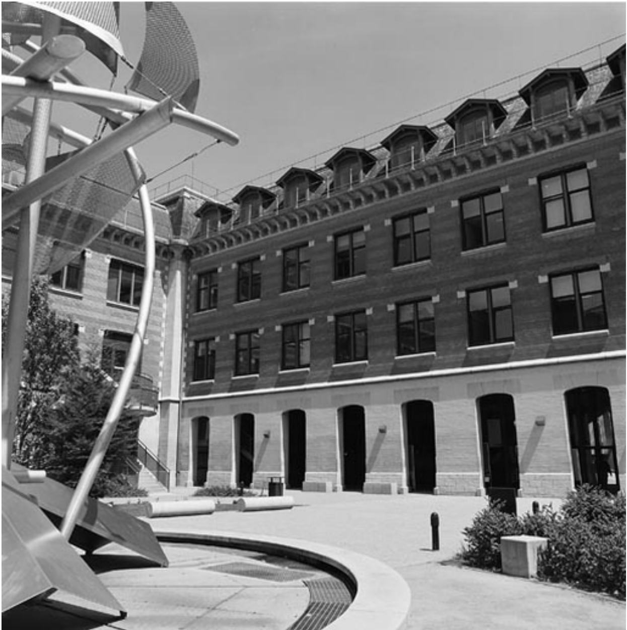
Vue de la cour intérieure
