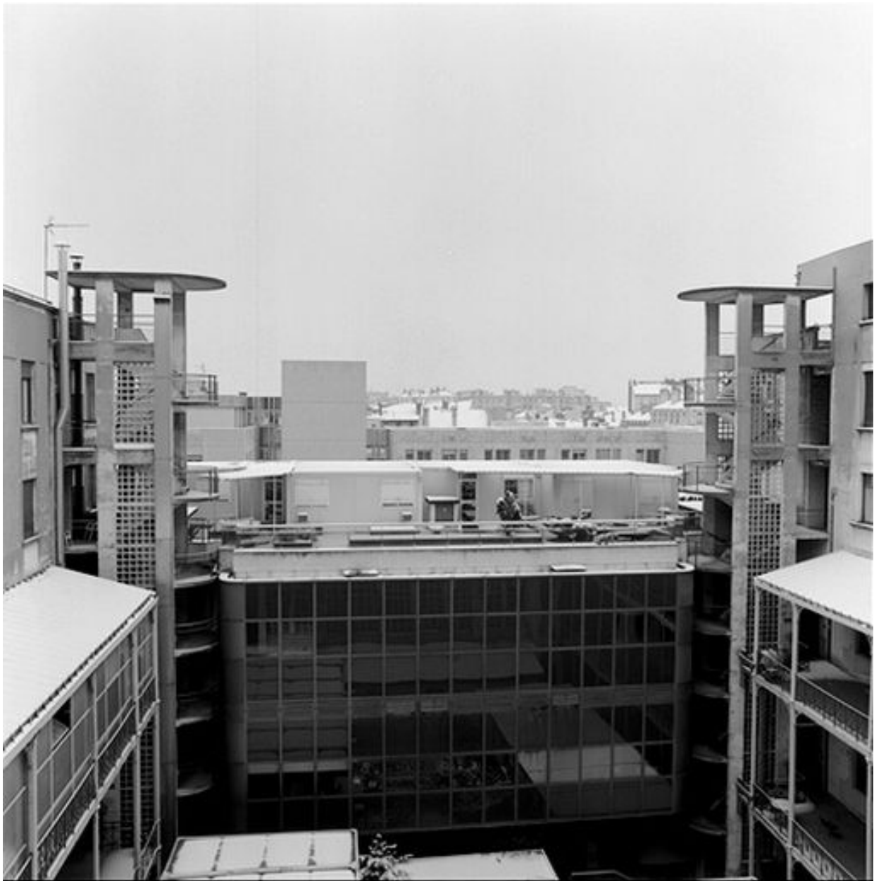
Bâtiment principal, vue prise depuis le corps principal vers Bâtiment principal, vue prise du corps central vers l'extrémité des ailes et le bâtiment ajouté le long de la rue Pasteur
