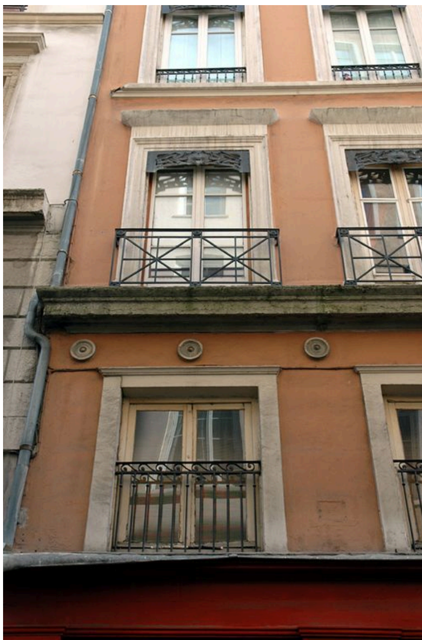
Vue partielle de l'élévation antérieure
