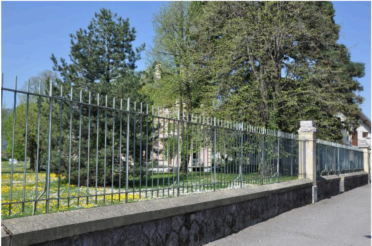
Mur de clôture
