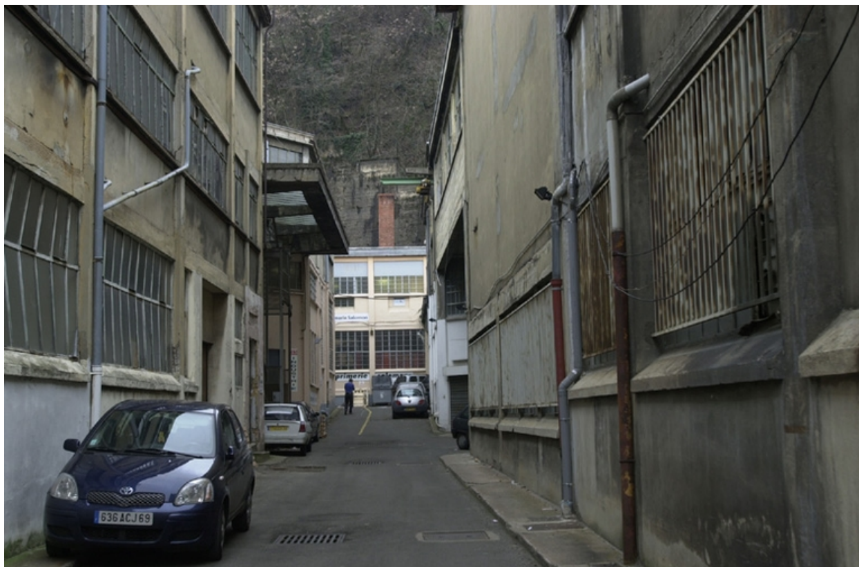
passage intérieur du site, vue est
