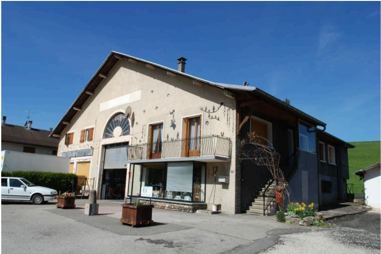
La Fay-Est, 2015 B3 1369, 1370, garage route d'Aix-les-Bains, vue d'ensemble.
