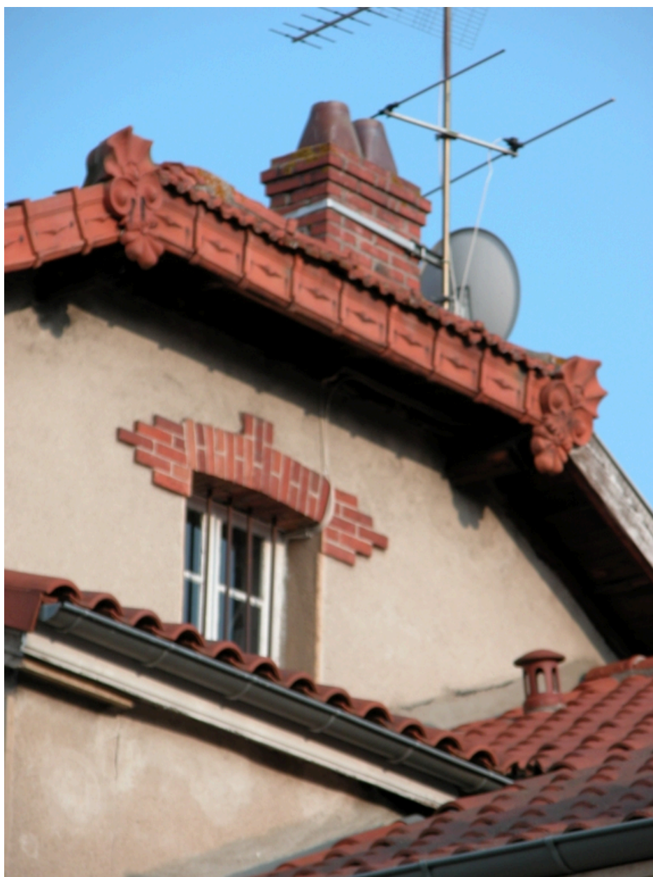
Détail d'une maison (1997 BA 171) : ornements en terre cuite.
