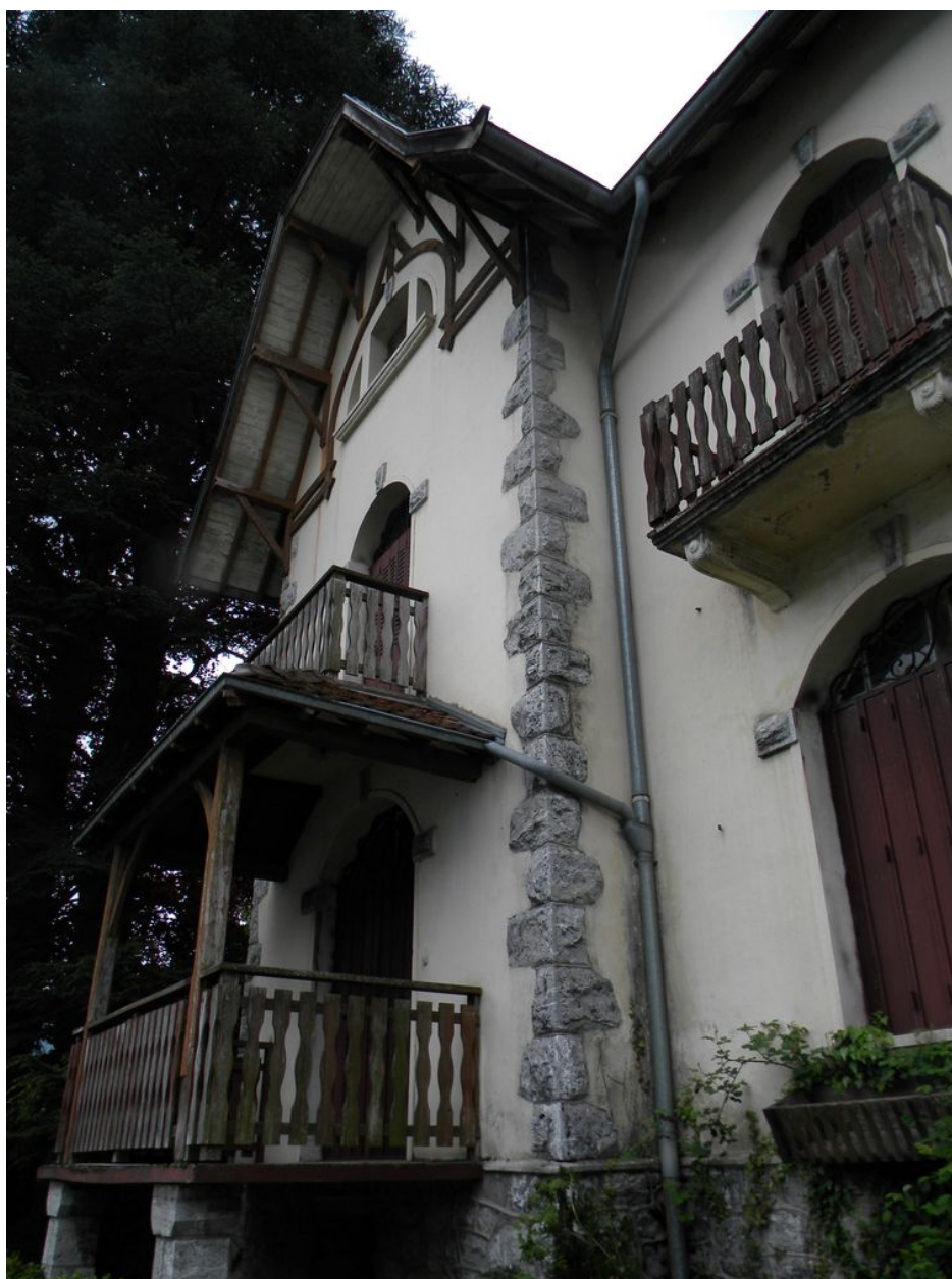
Vue de l'avancée en milieu de façade.
