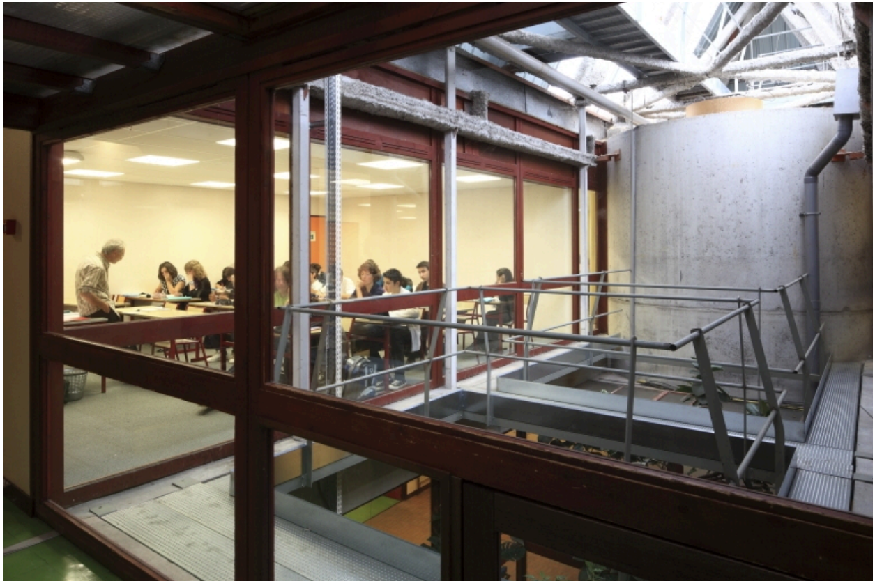
Bâtiment C, 1er étage, salle de classe, cuve et étage supérieur d'un puits de lumière avec galerie d'entretien.
