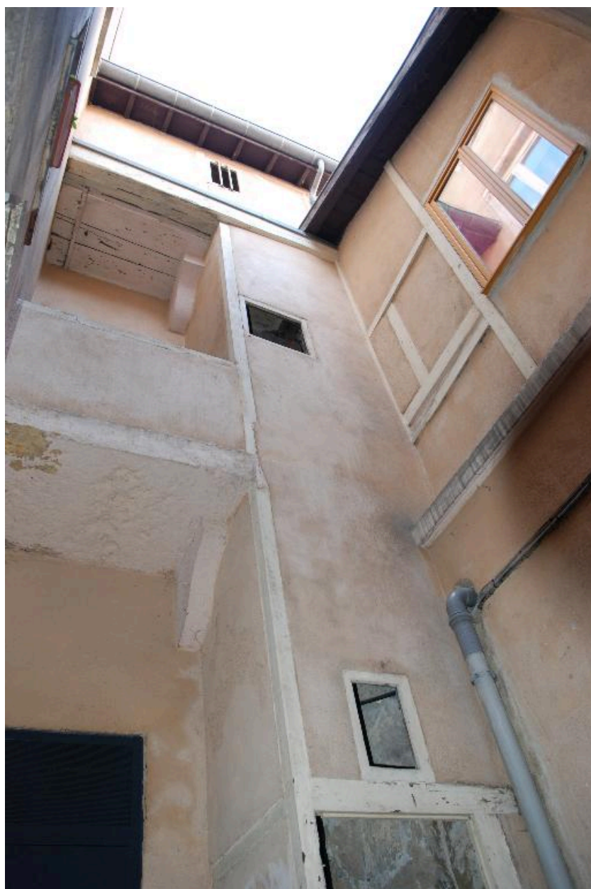
Vue de la cour, montrant les paliers de la tour d'escalier à gauche et la façade du bâtiment sur cour à droite
