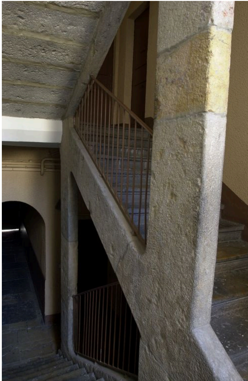
Vue d'ensemble de l'escalier
