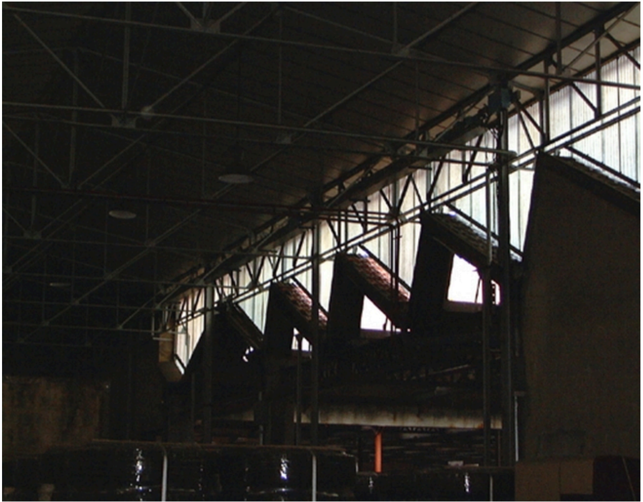
Passage couvert détail toit shed
