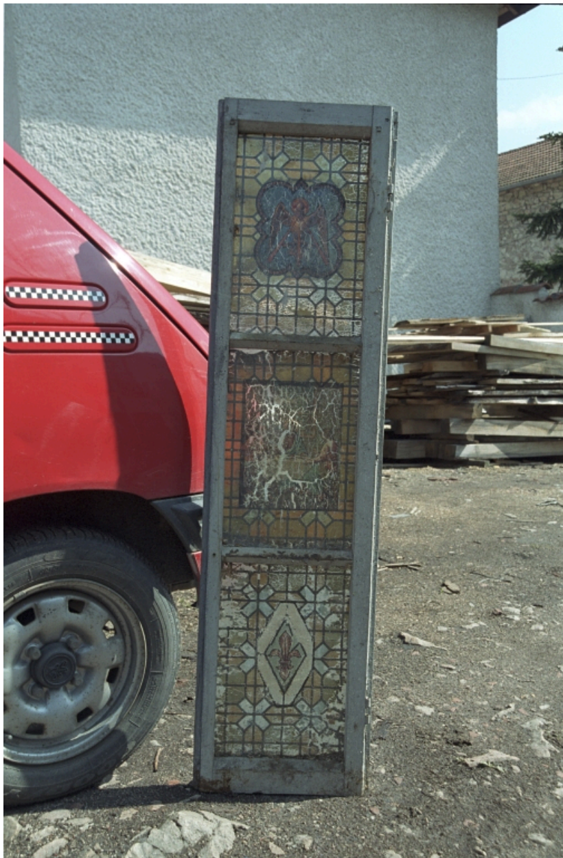
Anciens vantaux de la baie de la chapelle (déposés). Vantail de droite.
