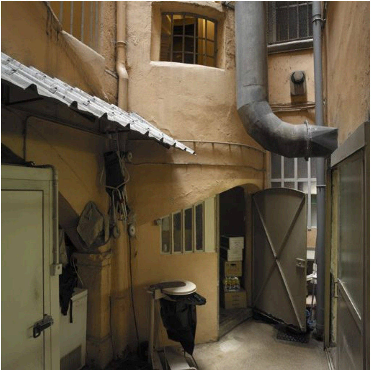
Cour, vue du rez-de-chaussée vers la tour d'escalier
