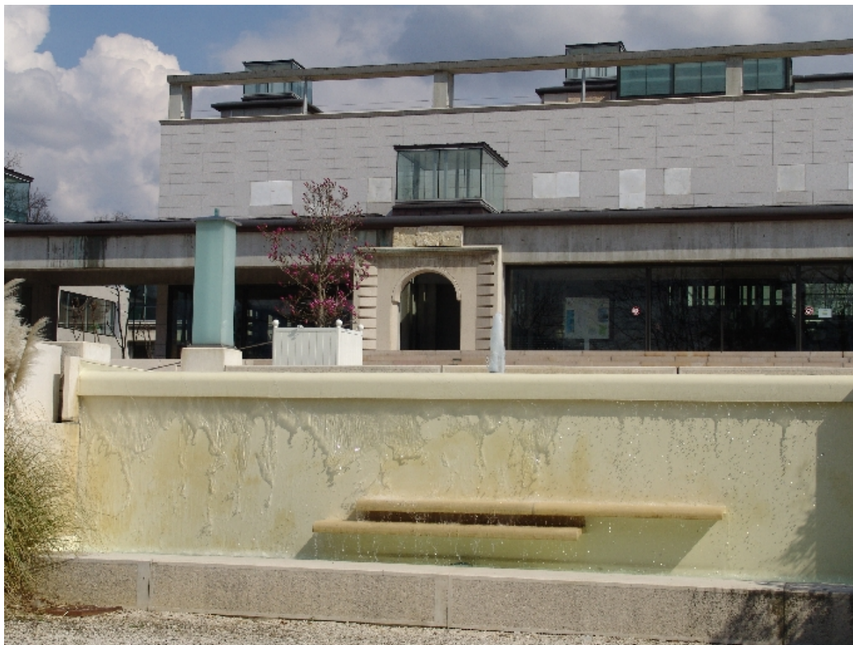
Bassin en façade
