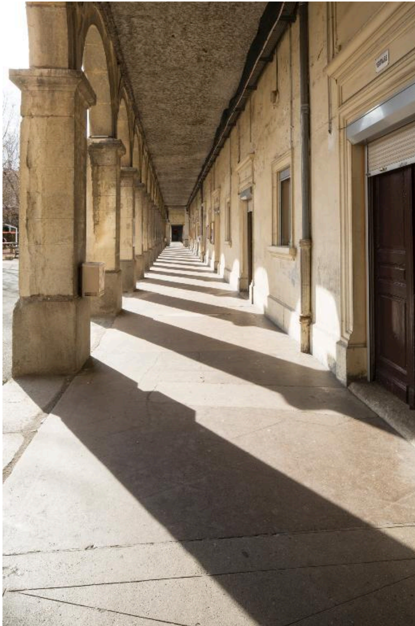
Bâtiment H, la galerie, vue depuis le nord vers le sud
