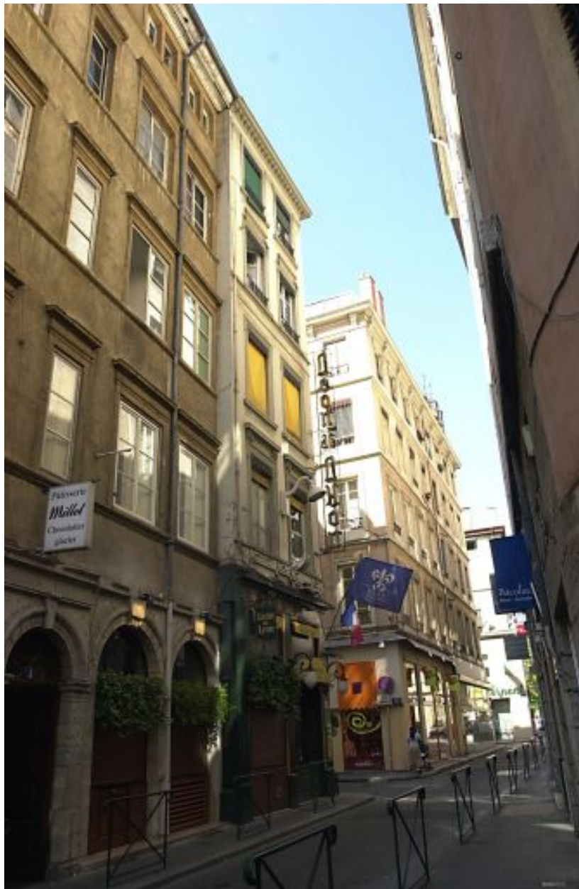
Façade sur la rue du Plâtre
