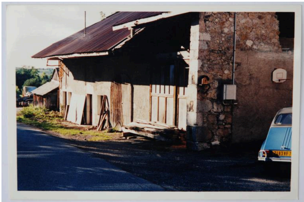
2015 A2 133 à 135, 1457, la Chiésaz-Nord, ferme. Photographie ancienne avant rénovation.
