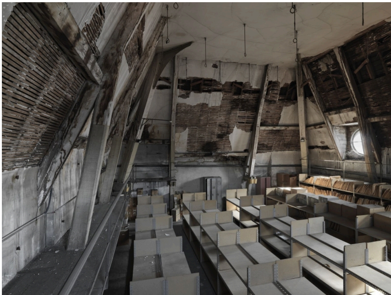
Bâtiment A'. Etage de comble du pavillon sud-est. Salle dite des Pendus
