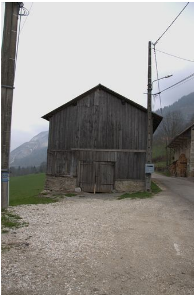
Mur pignon d'une remise
