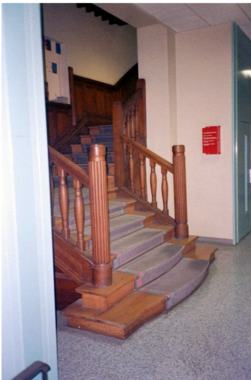
Escalier intérieur, départ de l'escalier
