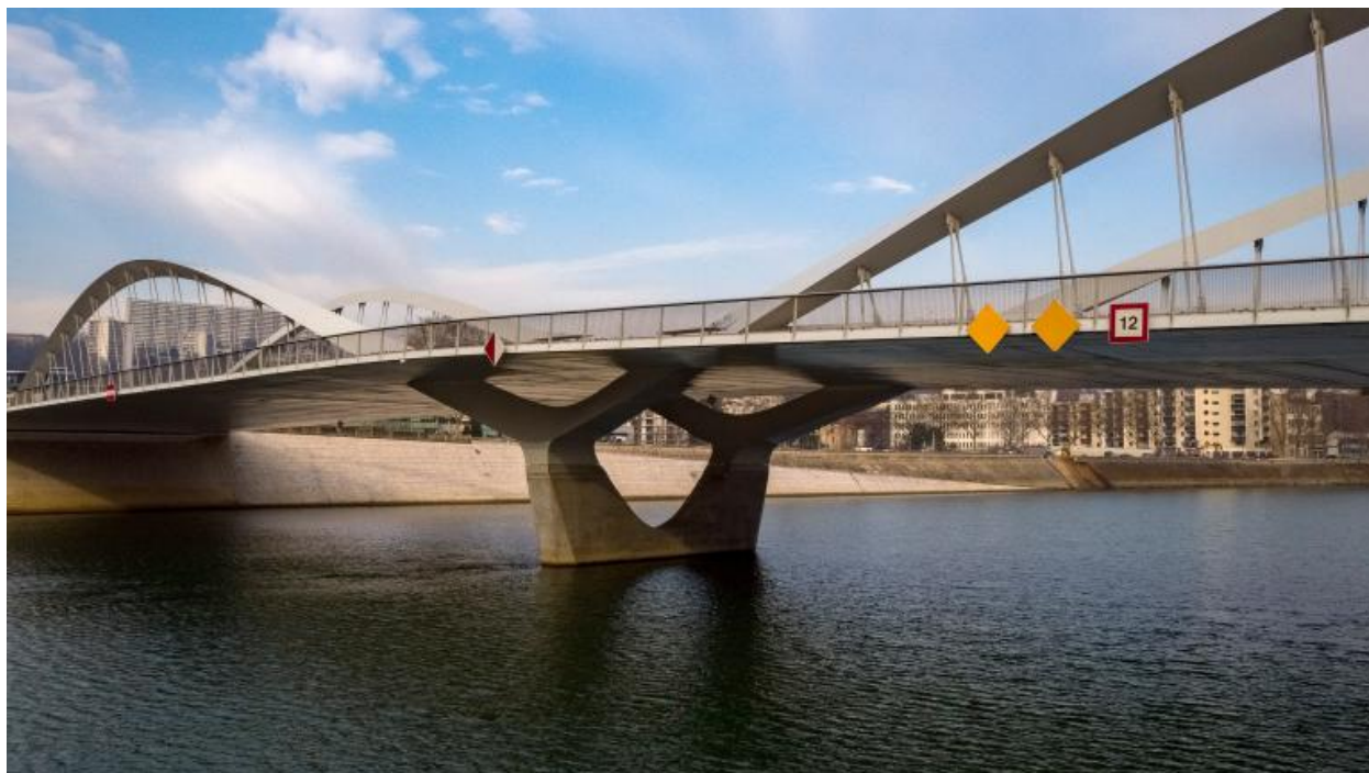
Vue sud-est du pont Schuman et de la pile en rivière à 14m de fond (drône)
