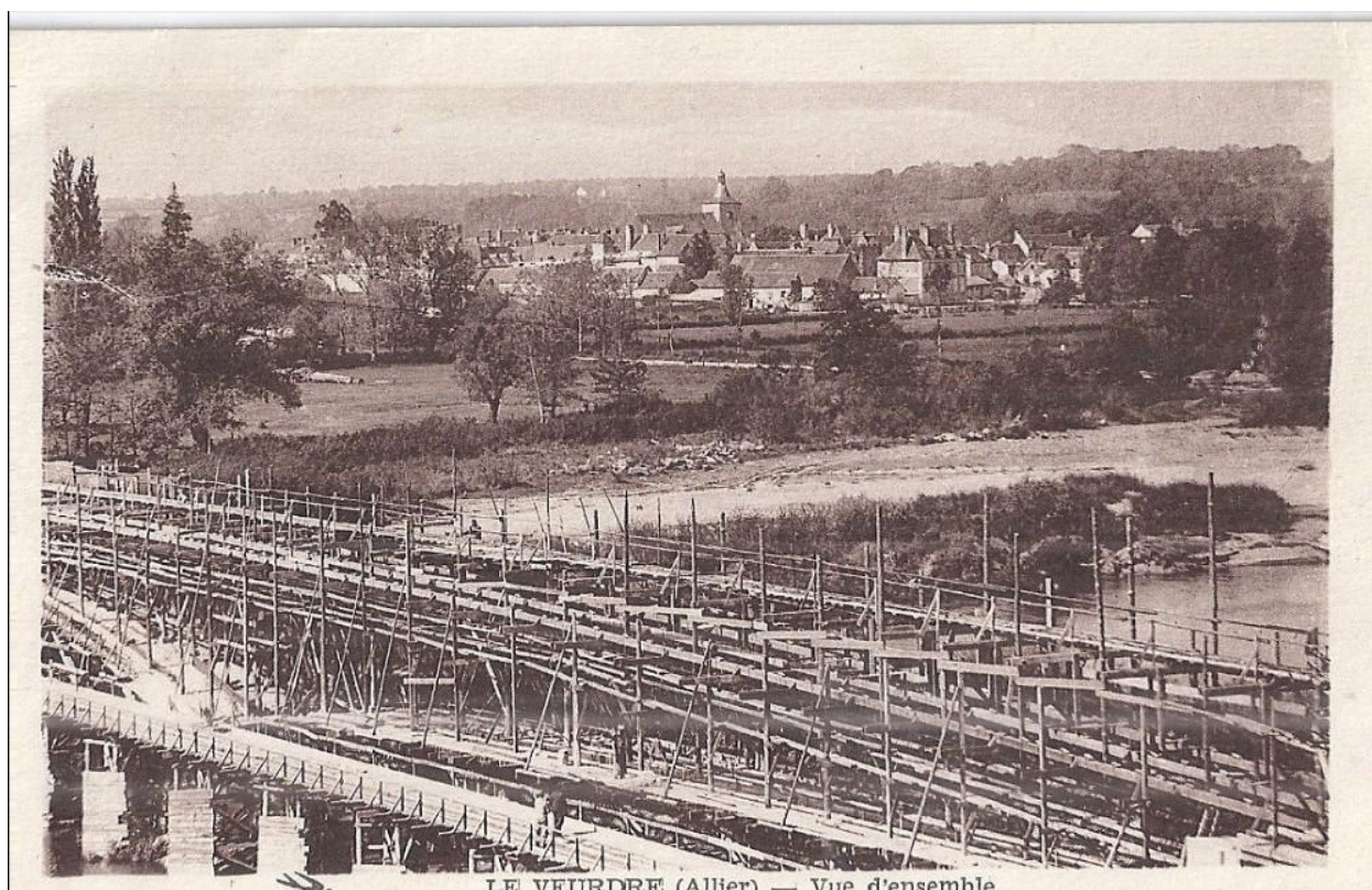
Vue de la reconstruction du pont n°3 : carte postale ancienne (éd. l'Hirondelle - Paris).
