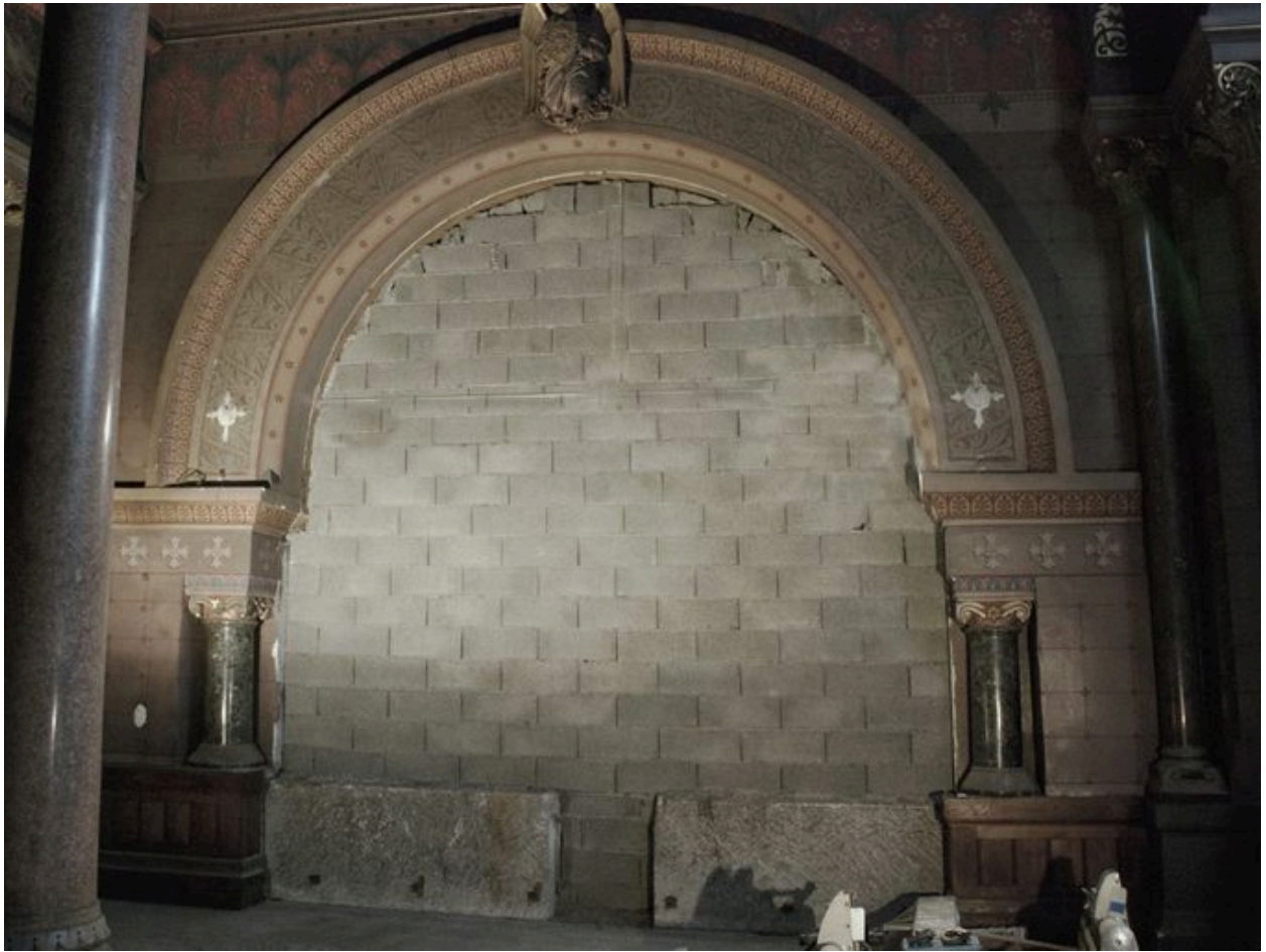
Choeur, mur sud, baie ouvrant autrefois sur le choeur des religieuses, aujourd'hui murée
