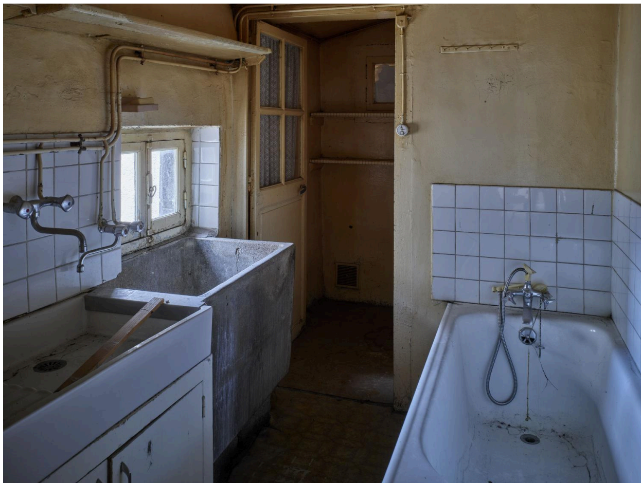
Corps de bâtiment sur cour, 2e étage : cuve en pierre, ancien lave-mains (à gauche sur l'image)
