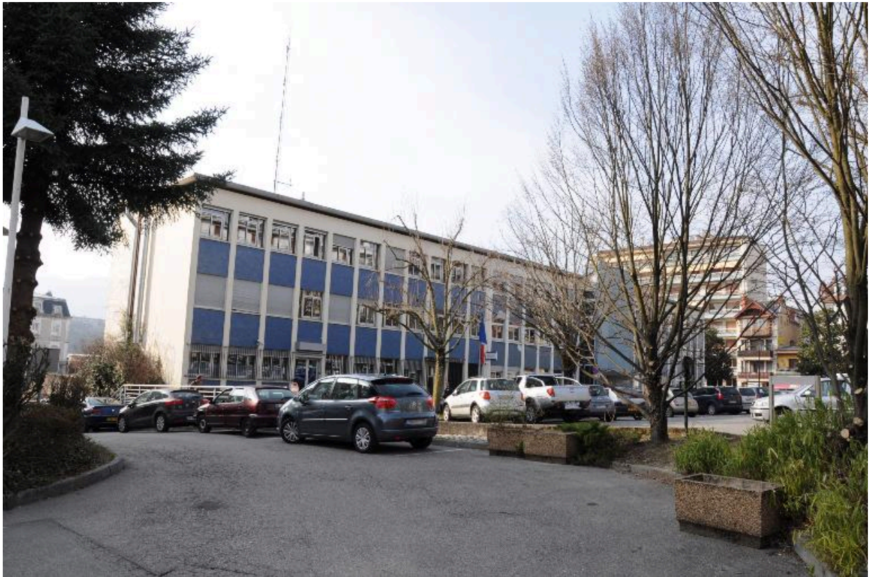
Vue de trois-quart depuis le sud-est (commissariat)
