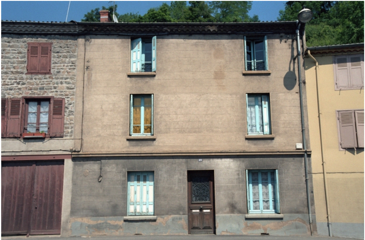
Boën, îlot 22, Lyon (rue de) 49. Vue générale de la façade sur rue.
