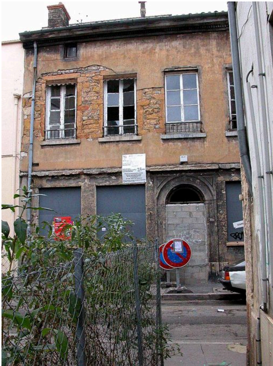
Partie nord de l'élévation antérieure
